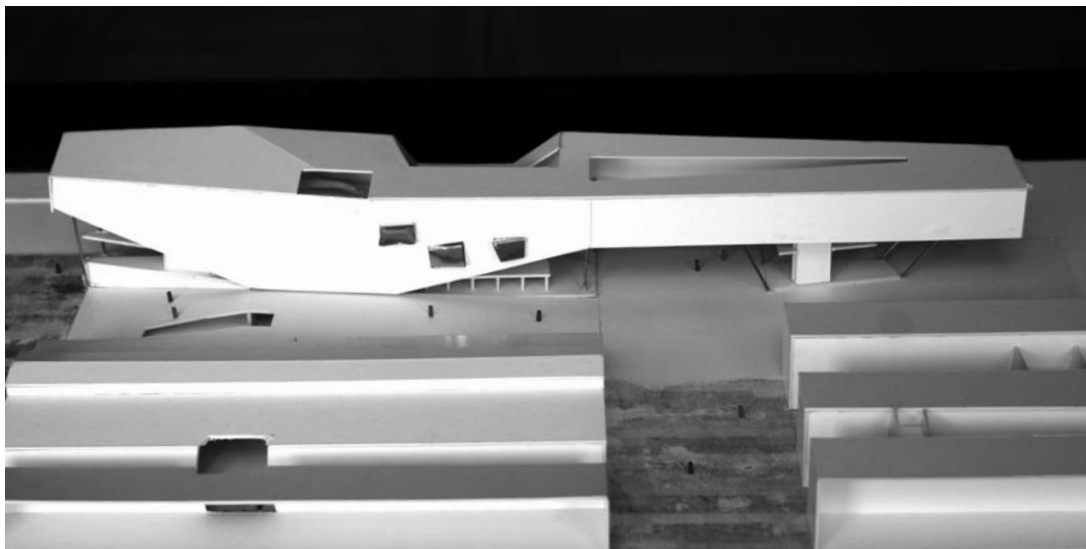
здания, продолжающие ангары, общий вид overview of the tram depot extension
